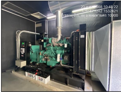
รูปที่ 31 เครื่องสำรองไฟฟ้า
